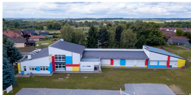
Zgrada Osnovne škole dr. Vinka Žganca nakon energetske obnove
